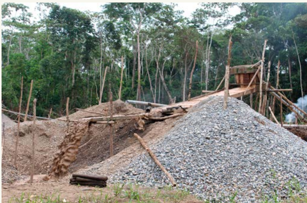
Foto 1: Proceso de lavado de material (arenas y gravas) con bombas de succión. Fuente: Archivo CINCIA. 2018.
